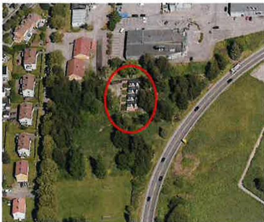
Flyfoto som viser eksisterende situasjon med de eksisterende boligmodulene
