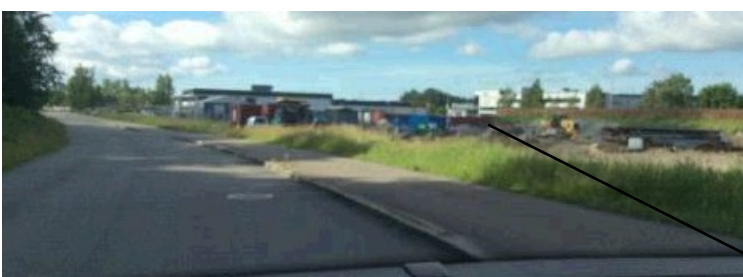
Lagring av rør og materialer –
